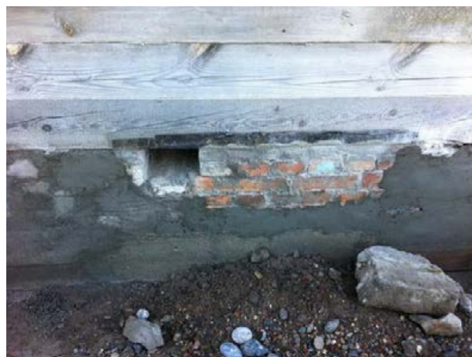
Отремонтированная часть фундамента
