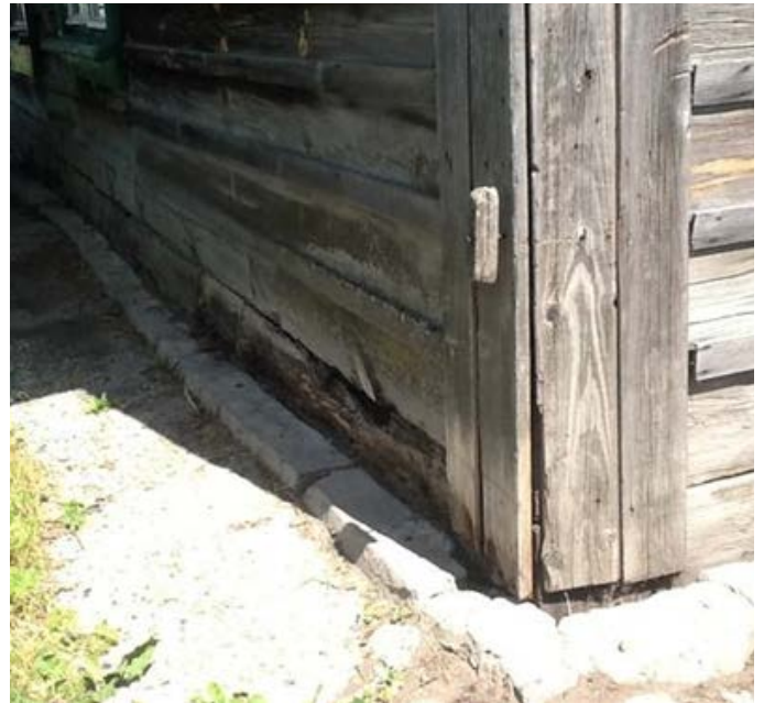
2015 год. Вторая (верхняя) отмостка и бетонный приступок.
