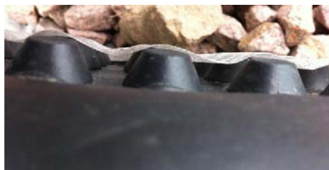
Каналы для отвода воды
