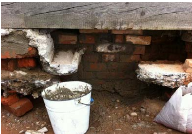
На цементный раствор уложила выпавшие кирпичи с внешней стены погреба
