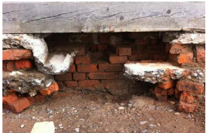
Для начала удалила все свободно лежащие кирпичи и куски старой отмостки. Смыла глину с бетонного основания
