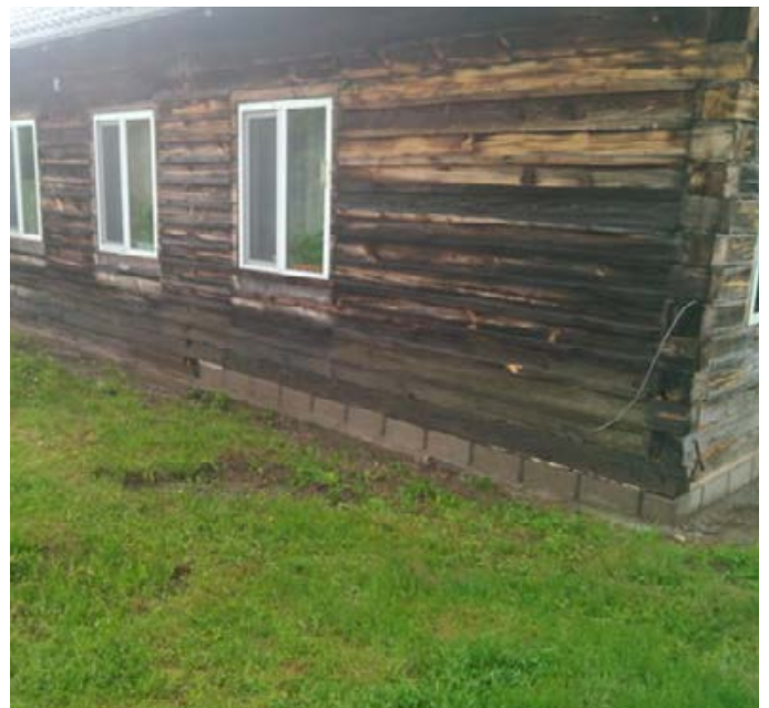
Прошлой осенью заменили часть нижнего венца на бетонные блоки, так как брус и пол в комнате частично съел грибок. Я знаю, что это неправильно, но в тот момент ничего лучшего мы не придумали
