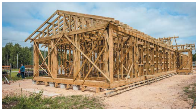
Рис. 18. Установка деревянного каркаса
