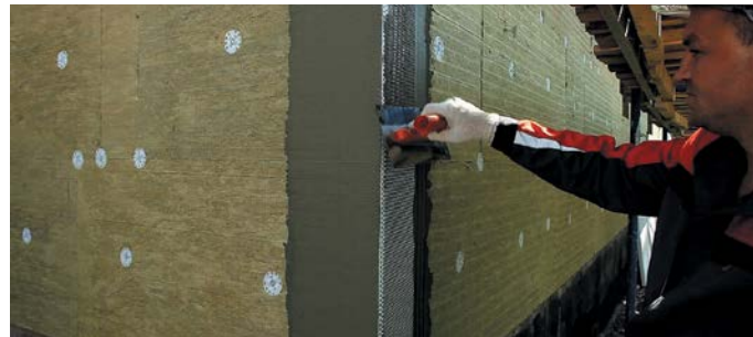
Рис. 35. Установка усиливающих профилей на углах здания
