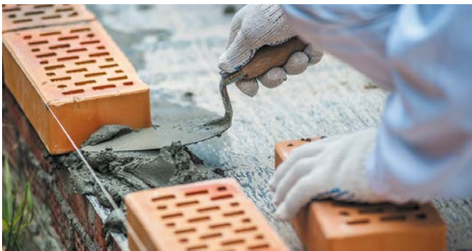
Рис. 9. Монтаж внешней версты
