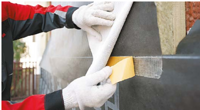
Рис. 5 б. Проклейка стыков полотен ветро-, влагозащитной мембраны
