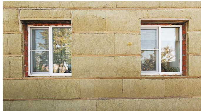
Рис. 4. Монтаж теплоизоляционных плит в горизонтальный каркас
