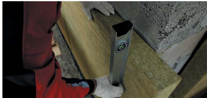
Рис. 29. Приклейка плиты тепло-, звукоизоляции к стене
