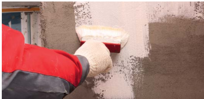
Рис. 38. Нанесение кварцевой грунтовки на поверхность базового штукатурного слоя
