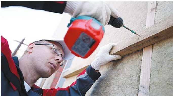
Рис. 3. Установка горизонтального каркаса
