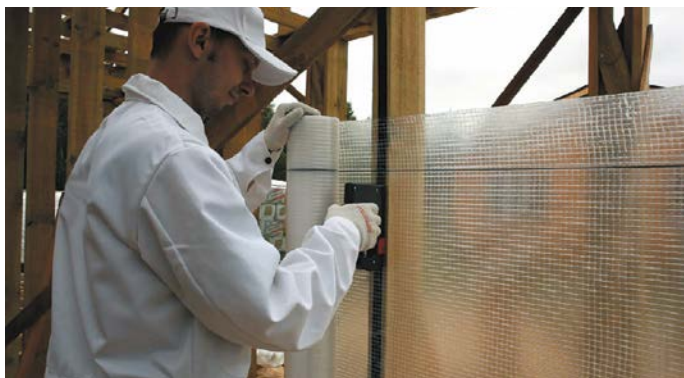
Рис. 19. Монтаж пароизоляционной пленки
