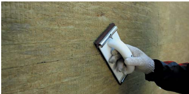
Рис. 32. Шлифовка стыков плит теплоизоляции наждачной бумагой
