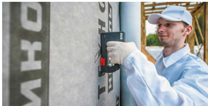
Рис. 21. Монтаж ветро-, влагозащитной мембраны
