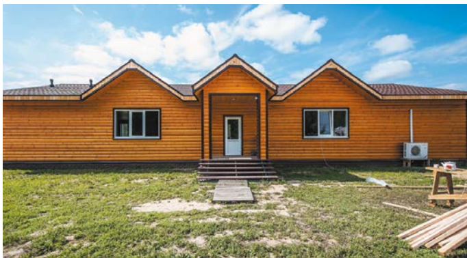
Рис. 22. Монтаж облицовочного материала
