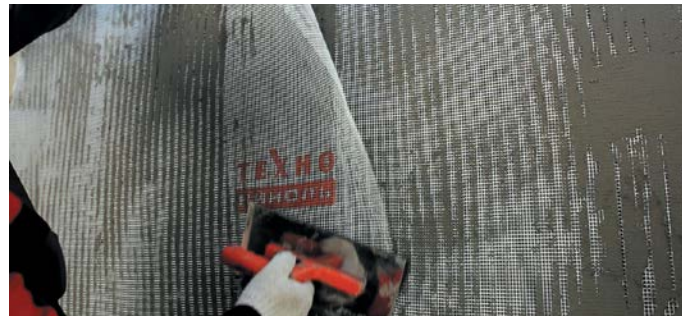
Рис. 37. Армирование базового штукатурного слоя стеклосеткой
