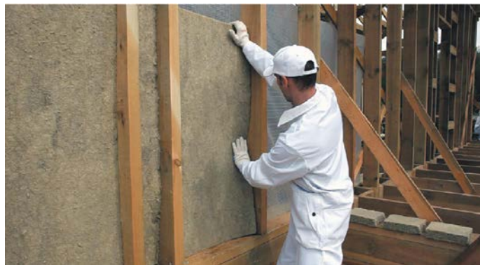
Рис. 20. Монтаж теплоизоляционных плит
