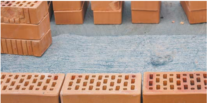
Рис. 7. Гидроизоляционная отсечка
