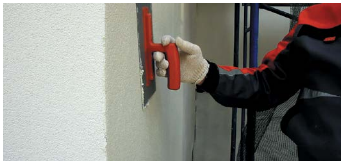
Рис. 39. Нанесение декоративного слоя штукатурки
