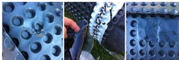
Использование ленты-герметика
