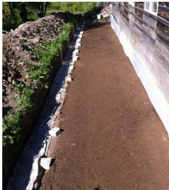
Уклонообразующий слой песка
