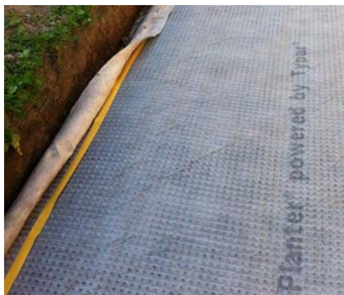
Зафиксировала геотекстиль дренажной канавки к геотекстилю мембраны на двусторонний скотч
