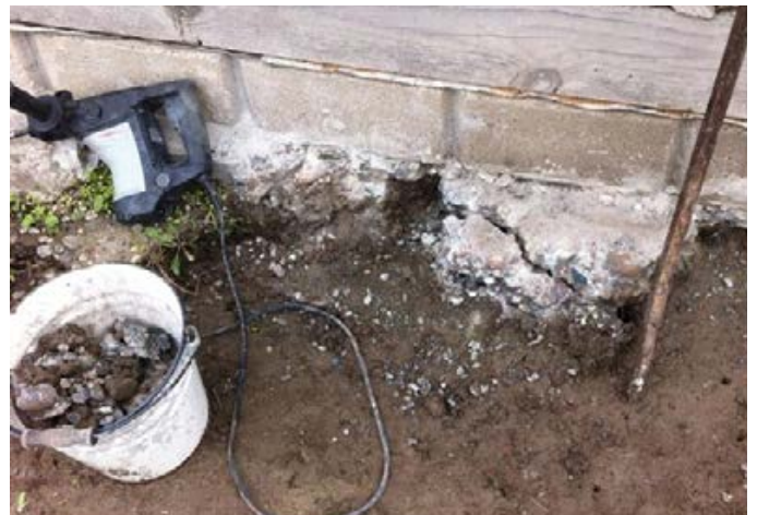
Удаление старого бетона
