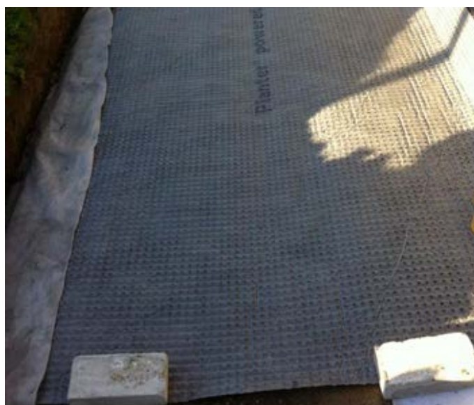
Сразу заправила мембрану под геотекстиль дренажной канавки.
