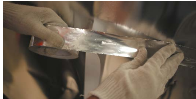
Рис. 3.2.б. Проклейка стыков пароизоляции
