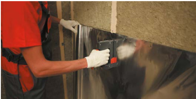
Рис. 3.1. Монтаж пароизоляции
