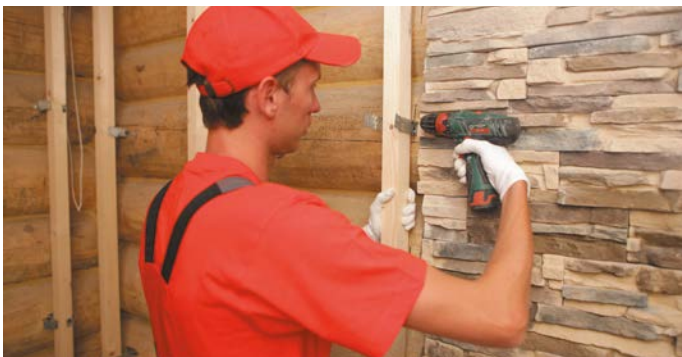
Рис. 1.1. Установка каркаса под теплоизоляцию
