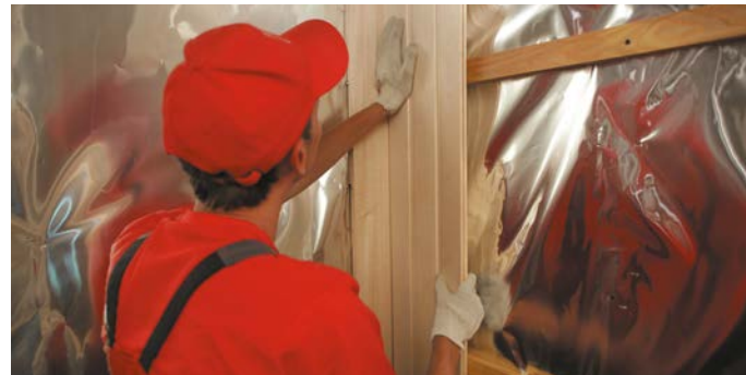
Рис. 4.1. Устройство внутренней обшивки
