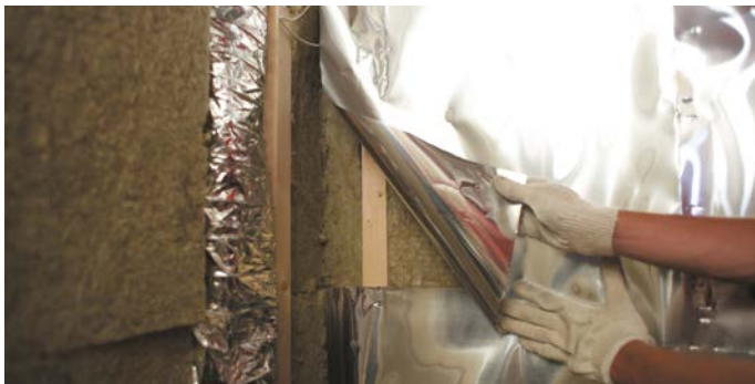
Рис. 3.2.а. Проклейка стыков пароизоляции
