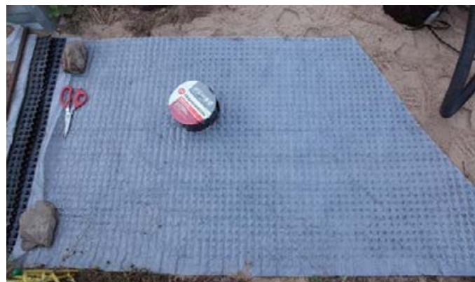
Сстыковка куском мембраны и ввод края в дренажную канаву
