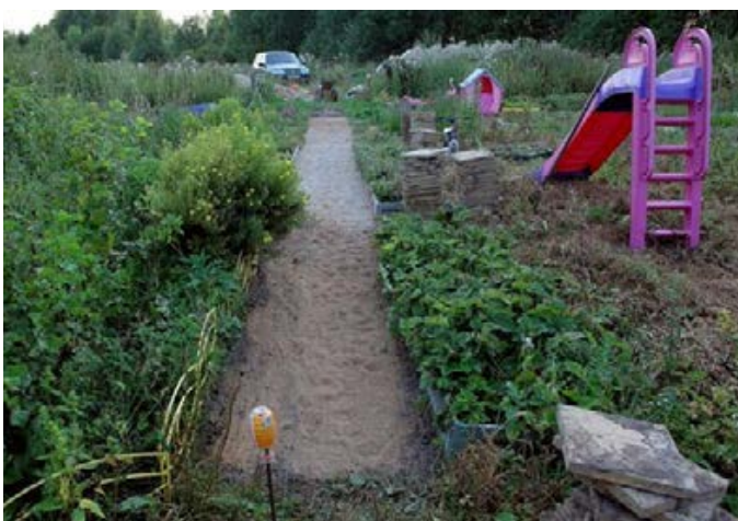
Отсыпка песчаной подушки по уровню разметочной нити
