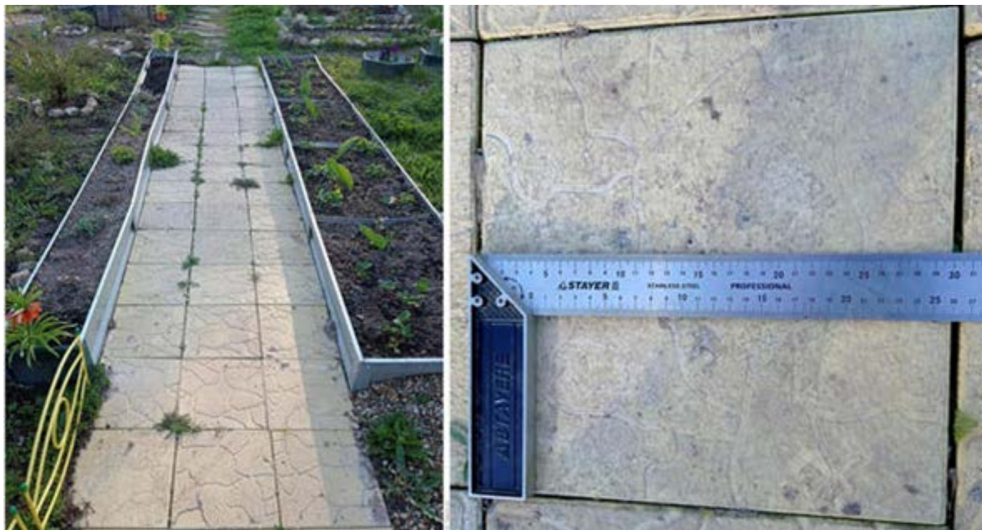
Плитки стали расползаться, сорняки начали завоевывать дорожку
