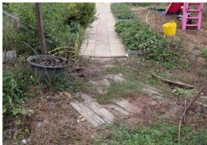
Сгнившие деревянные мостки с дренажной канавой
