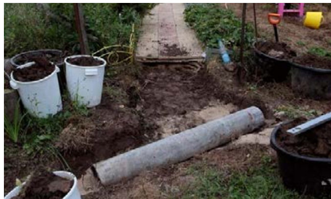
Укладка трубы в дренажную канаву
