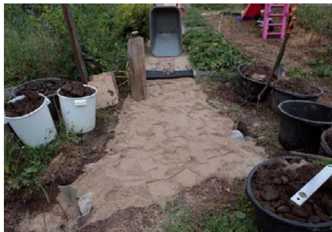
Подготовка поверхности под укладку мембраны
