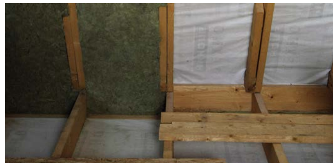
Рис. 2. Подготовленная система для дальнейшего монтажа теплоизоляции
