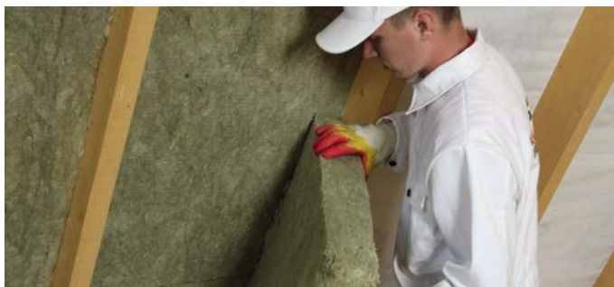
Рис. 3. Монтаж теплоизоляции враспор между стропилами
