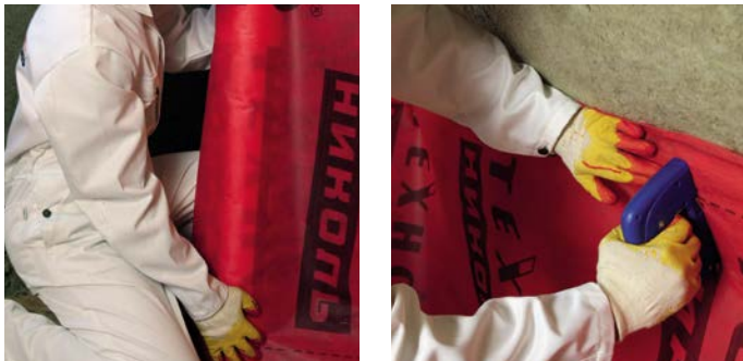
Рис. 5. Укладка и фиксация пароизоляционной пленки
