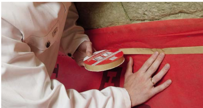
Рис. 5. Укладка и фиксация пароизоляционной пленки
