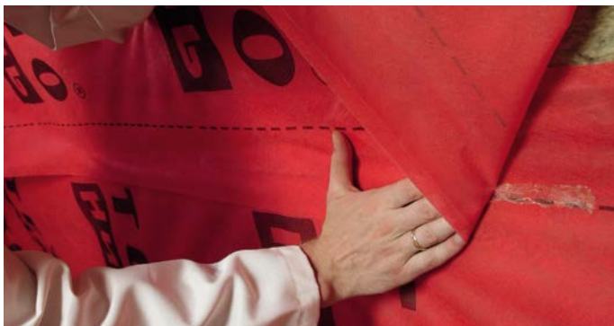
Рис. 6. Проклейка стыков пароизоляционной пленки
