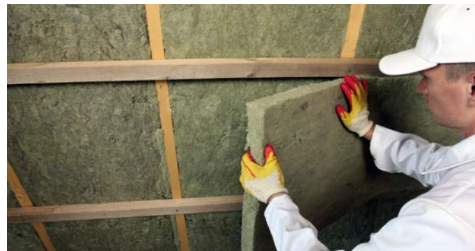
Рис. 4. Укладка второго слоя теплоизоляции
