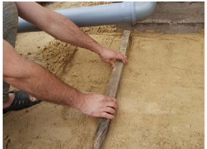
Выравнивали песок деревянным колышком подходящей метровой длины.
