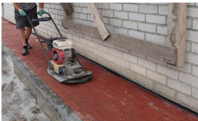
Уложили плитку, хорошо намочили из ведер и прошли с виброплитой.
