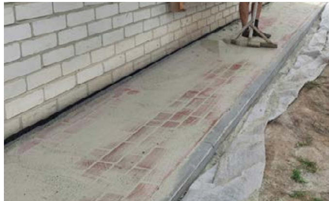
Забивание песка в швы между брусчаткой.
