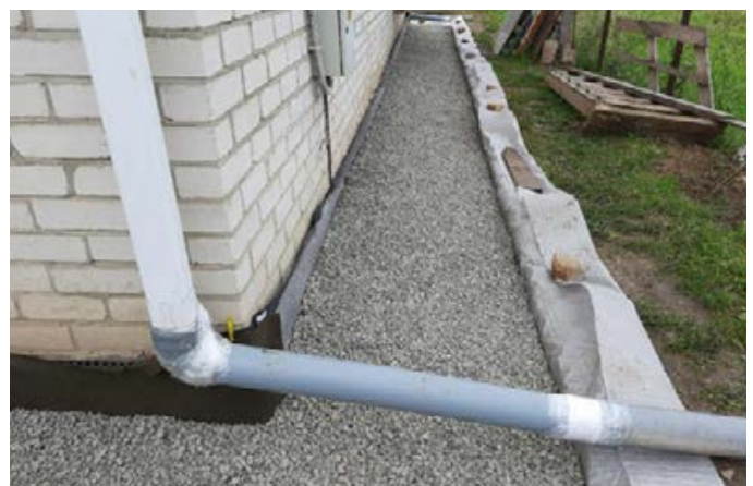
Защита фундамента с геомембраной ожидает финишных работ.
