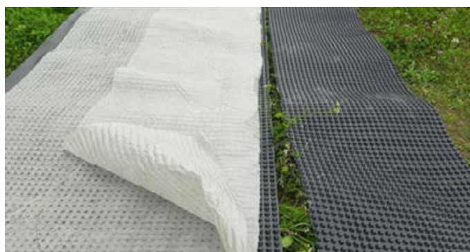
Поднимаем геотекстиль, чтобы отрезать 70 см мембраны.
