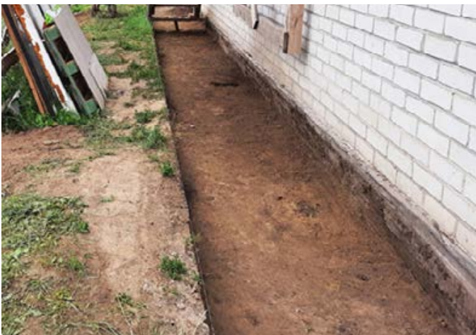
Траншея для отмостки, северная сторона, самая длинная.
