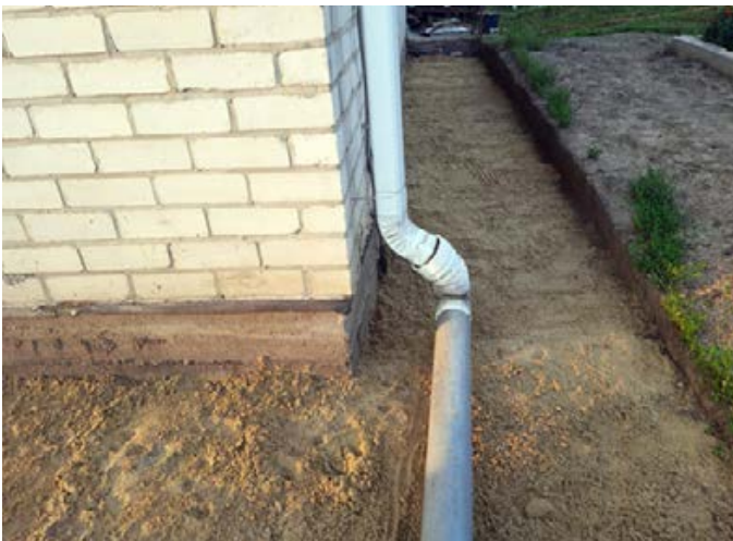
Насыпали сначала тонкий слой песка, потом добавили со стороны фундамента.
