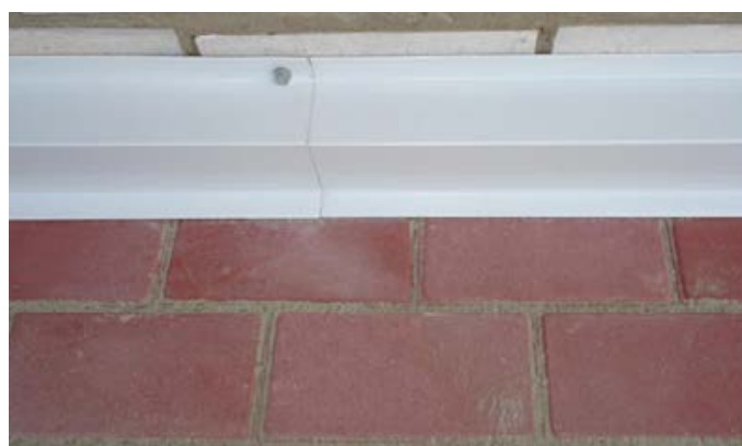
Защита от снега стыка геомембраны со стеной.
