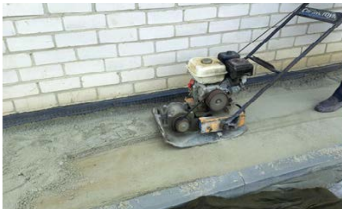
Виброплитой уплотнили песок
