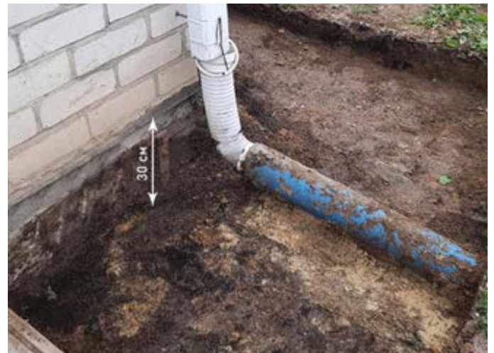
Восточная сторона траншеи до крыльца, короткий кусочек со вторым водостоком.
