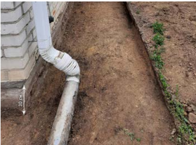
Западная сторона траншеи с водостоком (до колодца со скважиной, насосом и т. д.).
