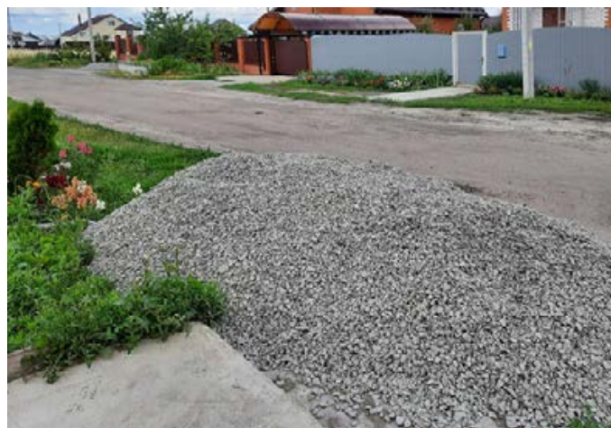
4 кубометра гранитного щебня для отмостки, 15 июля
