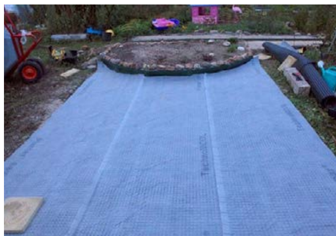
Укладка защитно-дренажной мембраны PLANTER Geo
