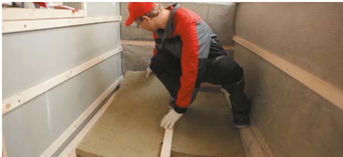
Рис. 9 Укладка теплоизоляционных плит
