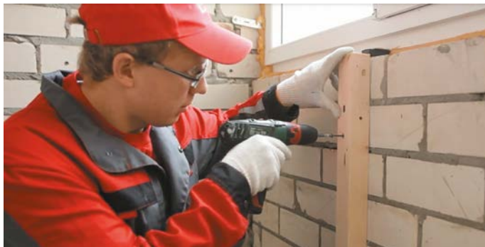
Рис. 1. Установка вертикального каркаса под теплоизоляцию
