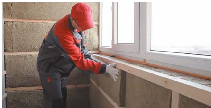
Рис. 4. Укладка плит теплоизоляции второго слоя
