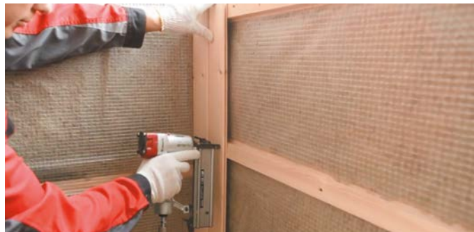
Рис. 7. Устройство внутренней обшивки
