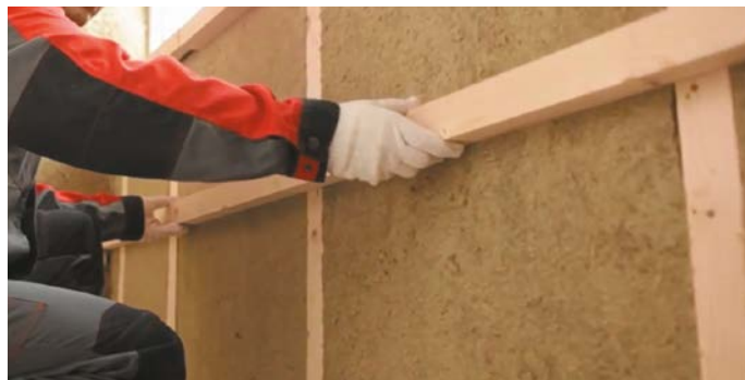
Рис. 3. Установка горизонтального каркаса под теплоизоляцию
