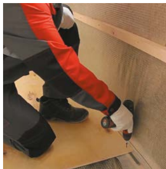
Рис. 13 . Установка покрытия пола
