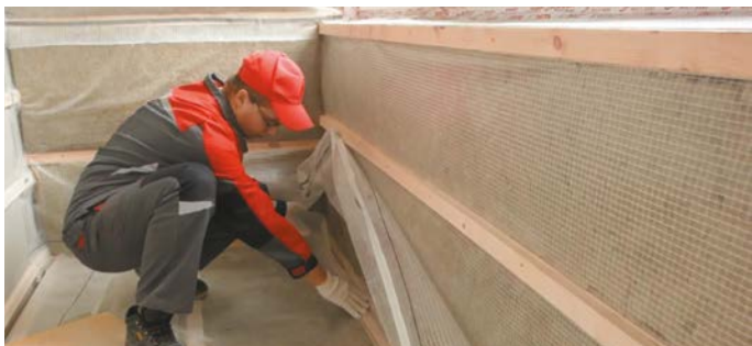
Рис. 10. Монтаж пароизоляционной пленки
