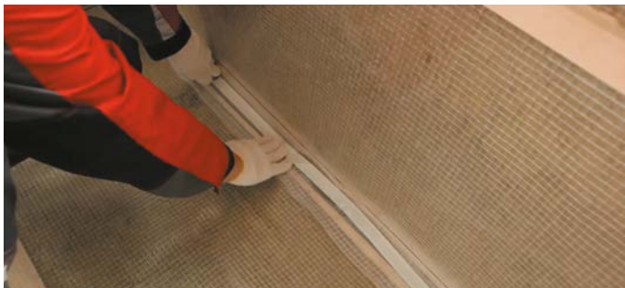
Рис.11. Проклейка нахлестов пароизоляции
