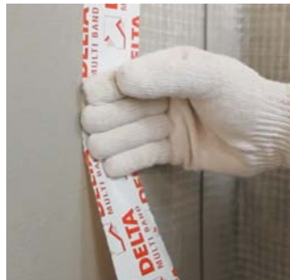
Рис. 12. Проклейка примыканий пароизоляции к стенам и окну
