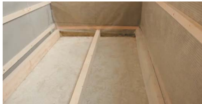
Рис. 8. Монтаж деревянных лаг на пол
