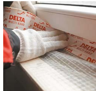
Рис. 12. Проклейка примыканий пароизоляции к стенам и окну
