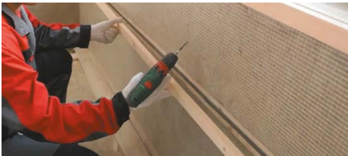
Рис. 6. Монтаж контррейки
