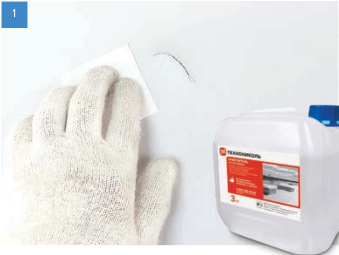
Подготовьте поверхность старой мембраны. Для этого используйте очиститель ТЕХНОНИКОЛЬ. Поверхность вокруг места повреждения должна быть сухой и чистой.
