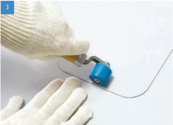
Снимите антиадгезивную пленку и прикатайте заплатку к мембране жестким роликом. Особенно хорошо прикатайте края заплатки.
