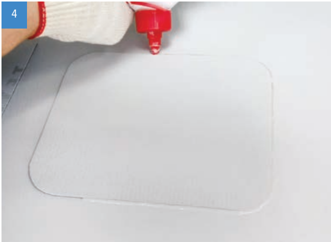
Для обеспечения дополнительной защиты от механических воздействий нанесите жидкий ПВХ ТЕХНОНИКОЛЬ по контуру заплатки.
