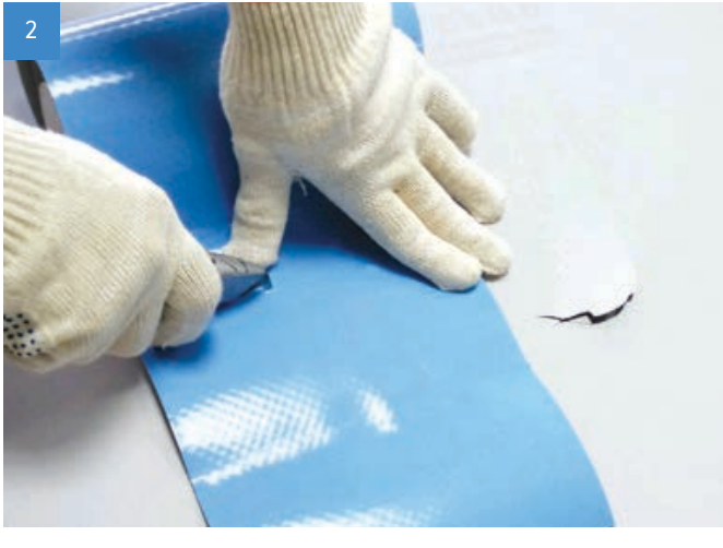
При необходимости ножницами вырежьте заплатку нужной формы. Закруглите углы заплатки. Она должна перекрывать место повреждения не менее, чем на 35 мм во все стороны.
